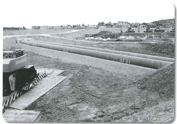
▶ 敷設された仮設ポリパイプ
