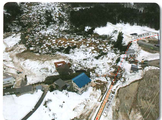
～地すべり災害の状況～
