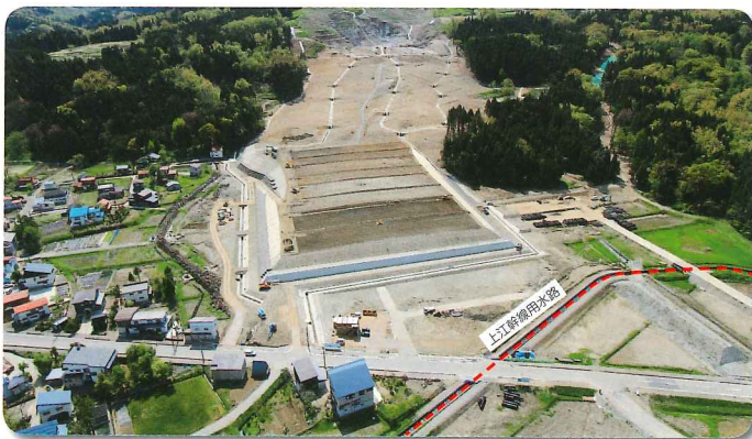
～地すべり災害復旧工事の全景～
