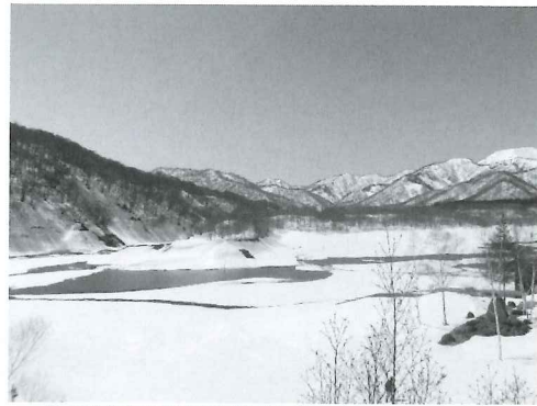
笹ヶ峰ダムの積雪状況
