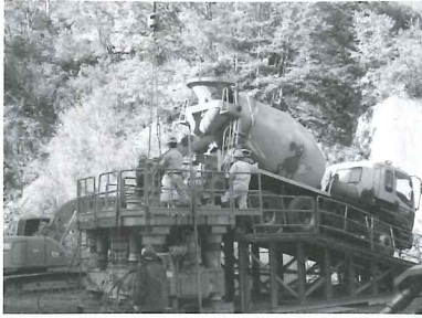
鉄筋建て込み後、コンクリート打設
