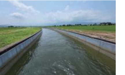
中江幹線用水路中流部
