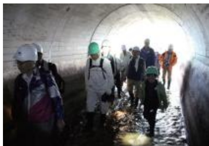
世界かんがい施設遺産「上江用水路（川上緑穴隧道）」の見学会
