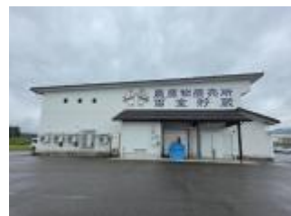
雪室貯蔵施設
