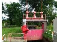
上江幹線用水路 直分ゲート
